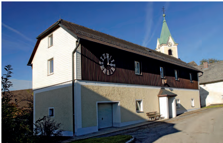
Ehemaliger Pferdestall, Umbau in ein Pfarrheim 1978, generalsaniert 2002
