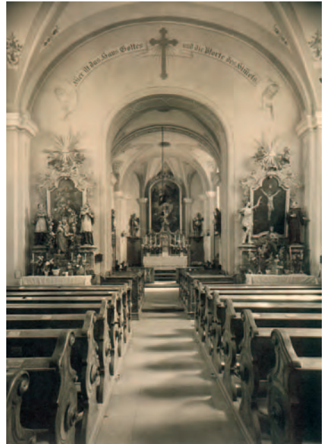
Pfarrkirche vor Renovierung um 1970
